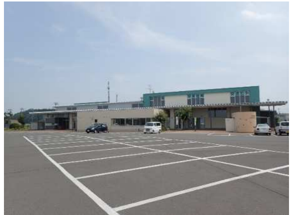
写-1.1.8 駅東地域交流センター
